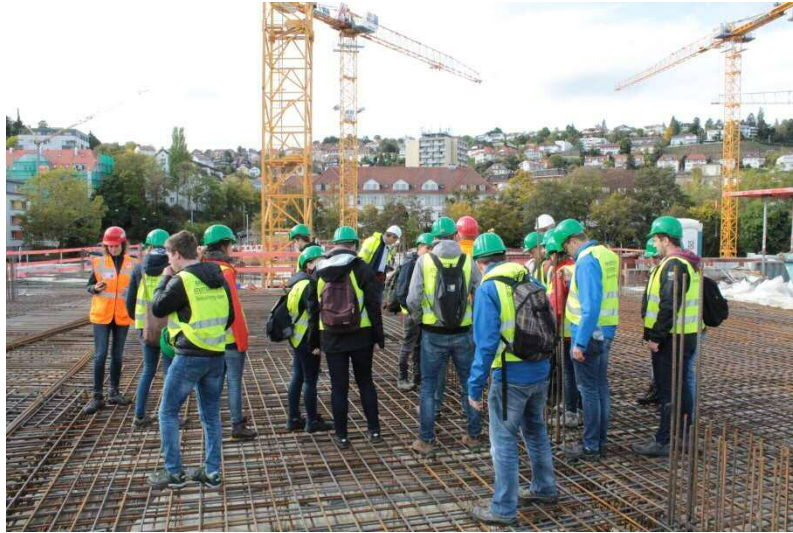
Bild 3: Besichtigung der aufwändigen Armierungsarbeiten der auskragenden Geschossdecke
