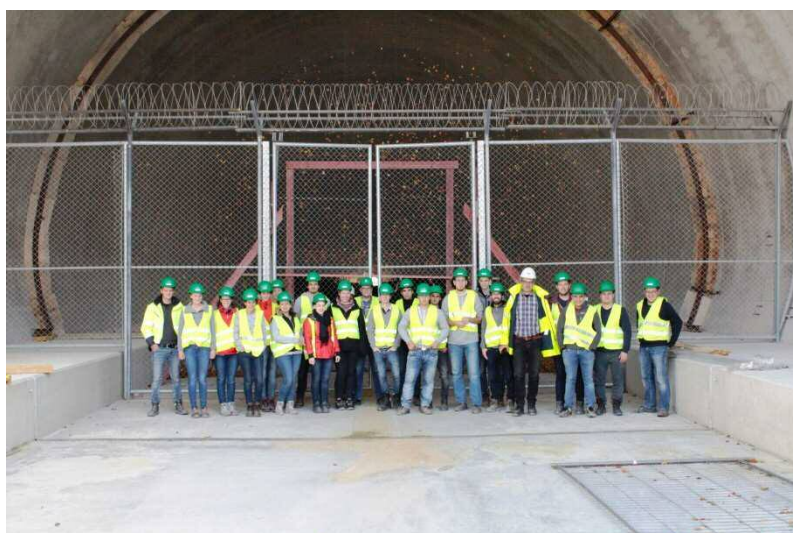
Bild 5: Tunnel Widderstall, Neubaustrecke Ulm - Stuttgart
