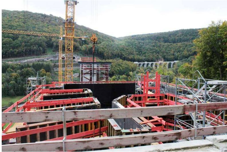
Bild 4: Blick vom Widerlager Boßlertunnel über die zukünftige Filstalbrücke
